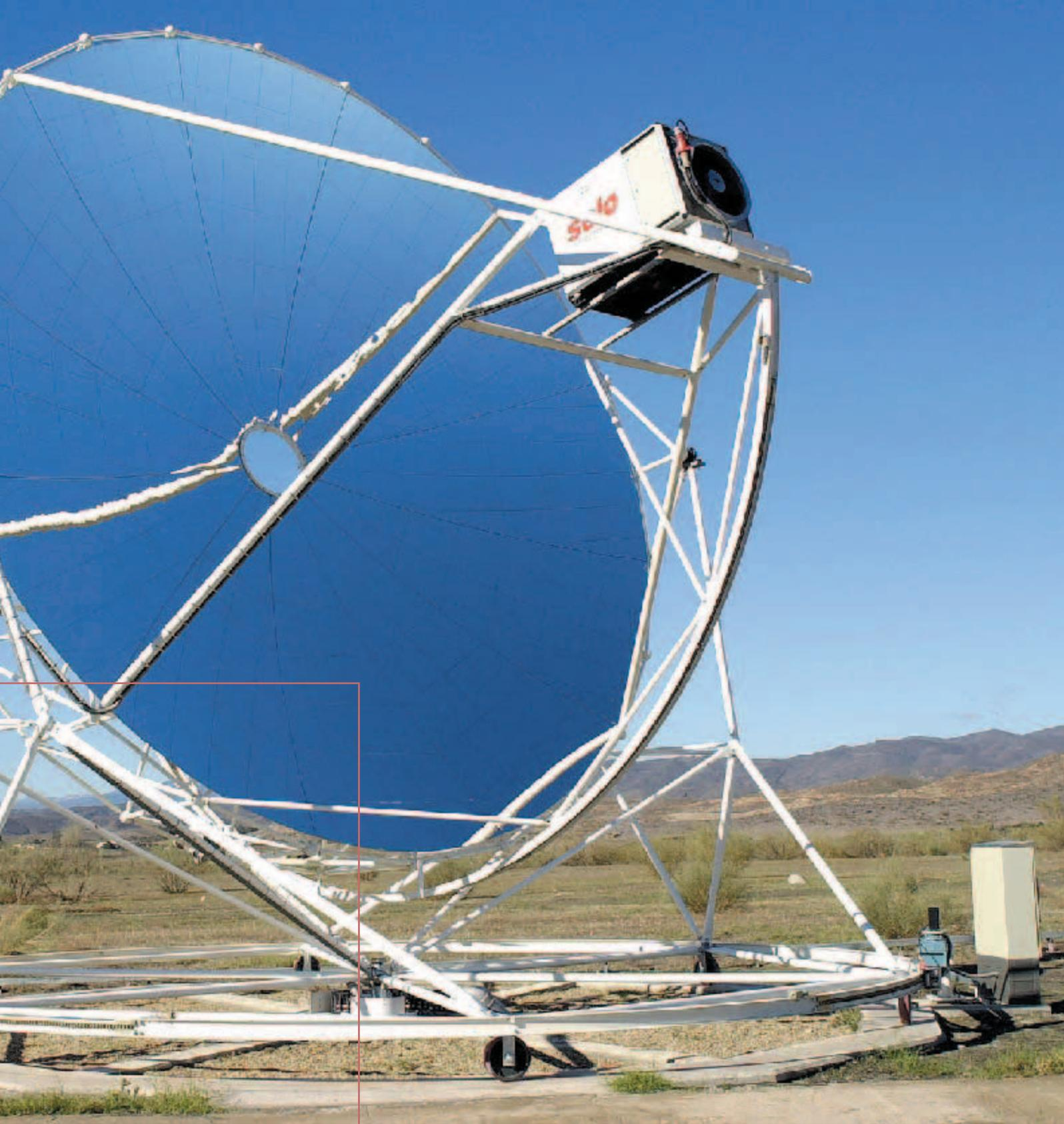
Abb.: EuroDish mit Stirling-Motor (zehn Kilowatt elektrisch) im Testbetrieb auf der Plataforma Solar de Almería, Spanien.
