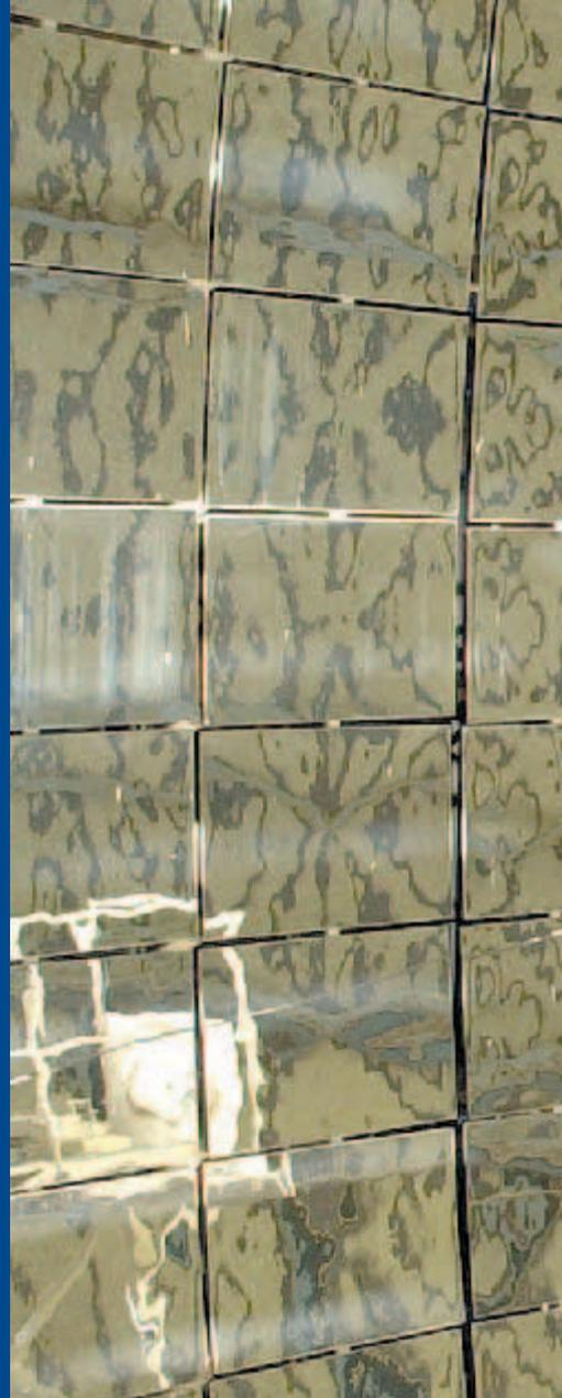
Abb: Konzentratorspiegel des Sonnenofens auf der Plataforma Solar de Almería (PSA), Spanien.
