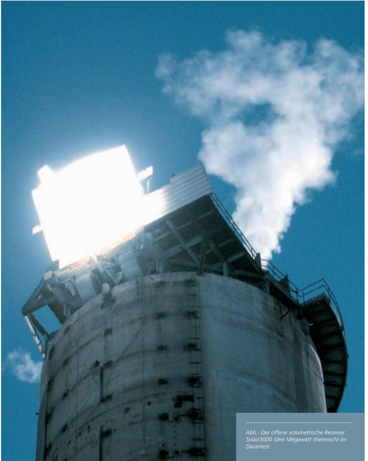
*Abb.: Der offene volumetrische Receiver Solair3000 (drei Megawatt thermisch) im Dauertest.*
