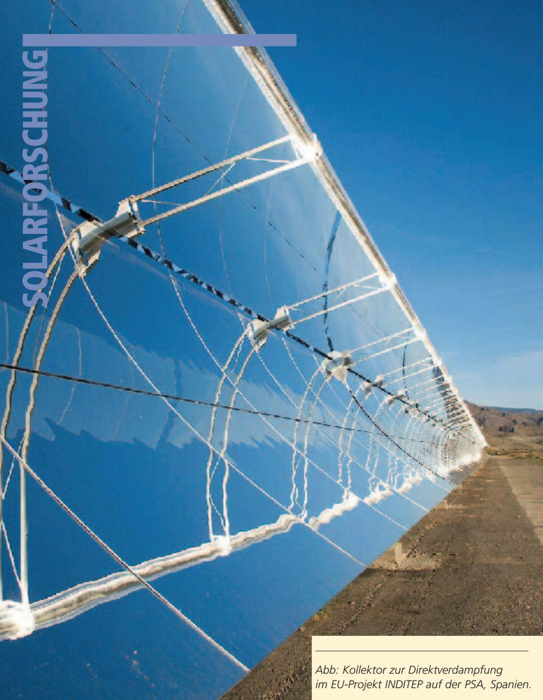
Abb: Kollektor zur Direktverdampfung im EU-Projekt INDITEP auf der PSA, Spanien.
