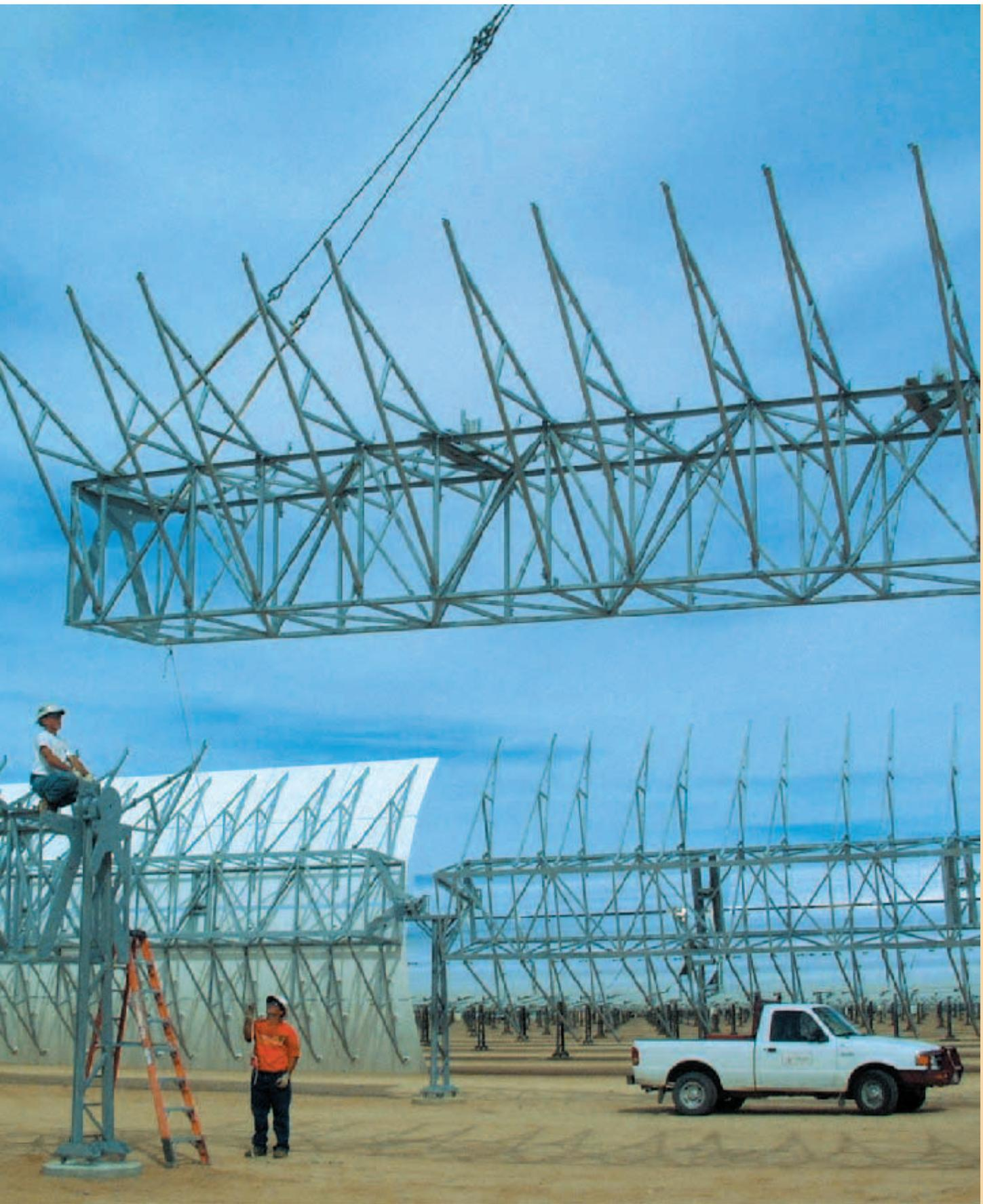
Abb.: Montage eines Kollektors SKAL-ET150.
