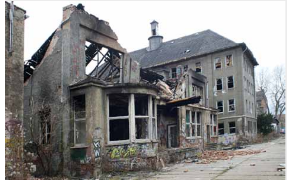
Das verfallene Firmenareal, 2001
