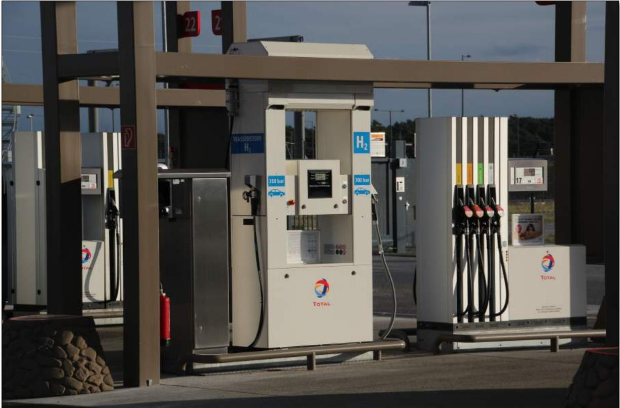
Abbildung C4.03 Zapfanlage einer Wasserstofftankstelle
