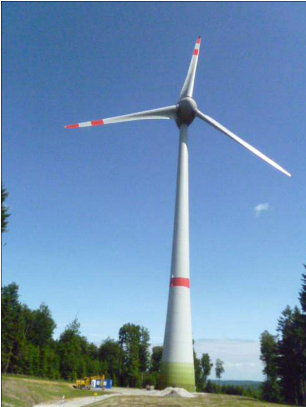
**Abbildung C3.05** Moderne Windkraftanlage mit 7,5 MW Leistung
