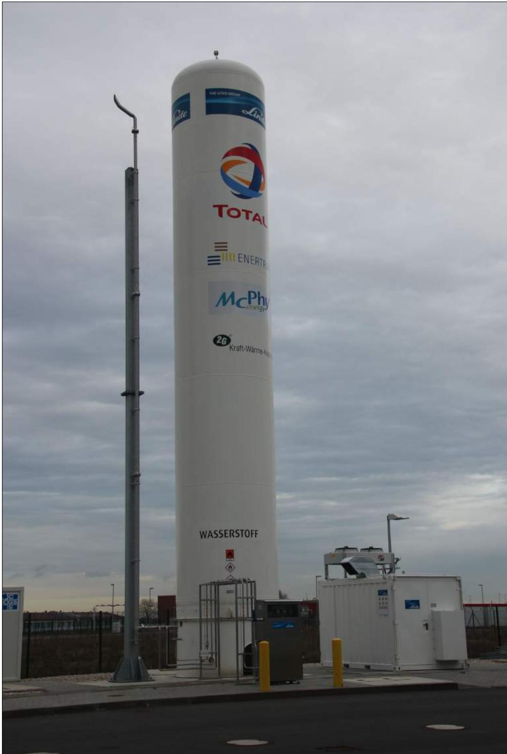
Abbildung C4.04 Wasserstoffspeicher bei der Tankstelle
