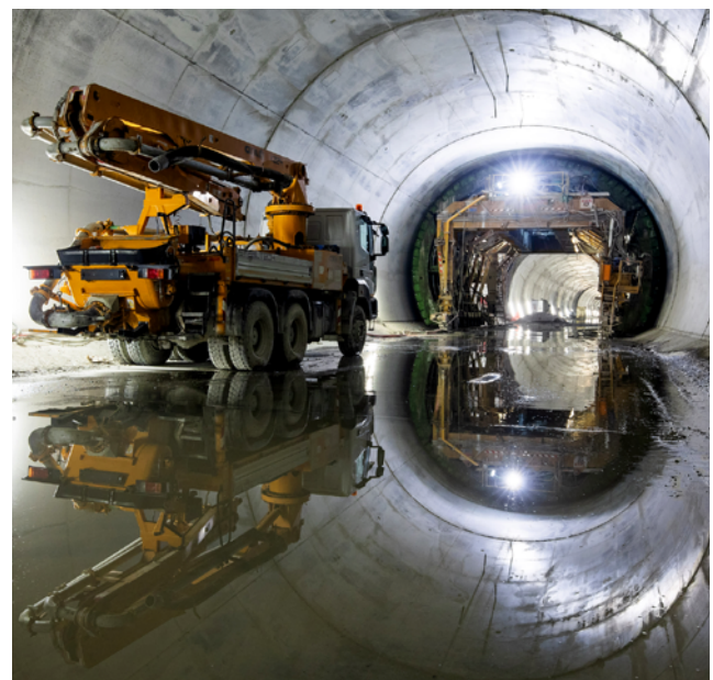
▲ Abbildung 14: Das Drainagewasser des Brennerbasistunnels könnte Innsbrucker Stadtviertel zukünftig mit Energie versorgen. Ein Forschungsverbund unter der Leitung der TU Graz lotet die Möglichkeiten aus.
