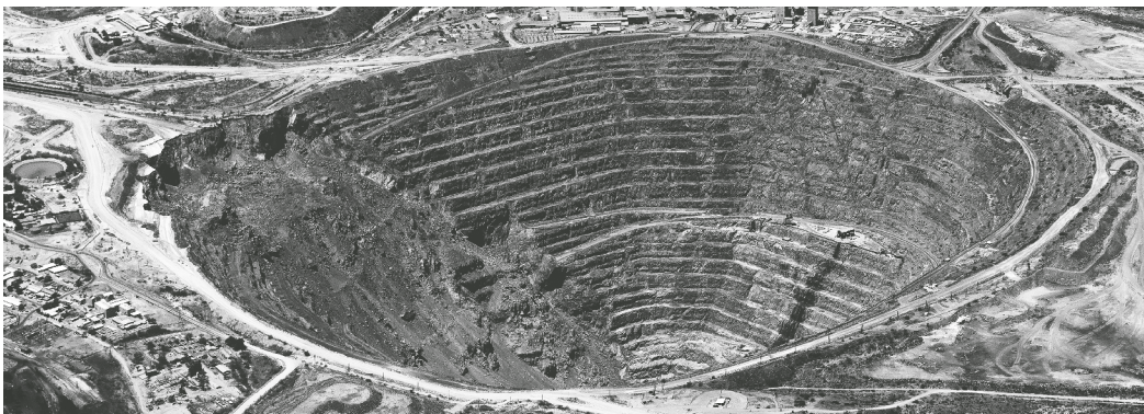
Abb. 1: Luftaufnahme einer Kupfermine in Palabora, Südafrika
