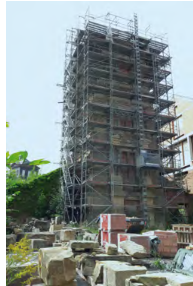
Turm während der Sanierung
