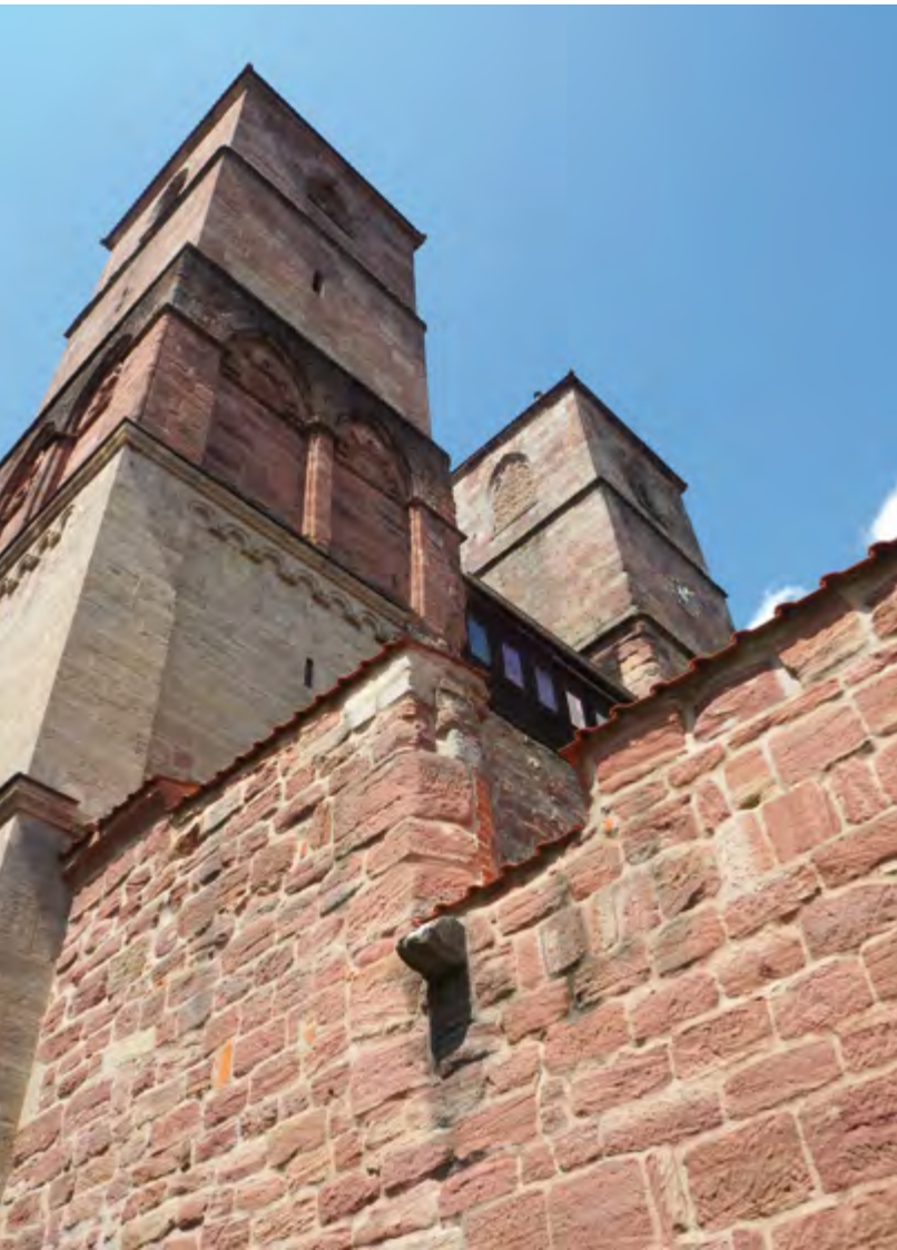
Kloster Veßra, Mauerkronensanierung an der Klosterkirche
