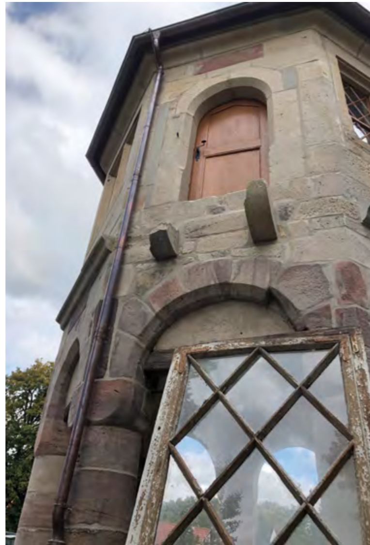
Schloss Bertholdsburg Schleusingen, Bemusterung der Fenster am Brunnenhaus
