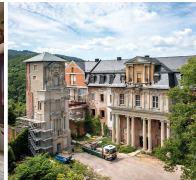
Schloss Schwarzburg, Schloss mit Turm während des Einbaus der Stahlbrücke
