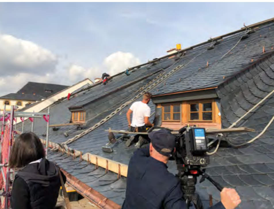
Schloss Friedenstein Gotha, fertiggestelltes Dach am Westturm
