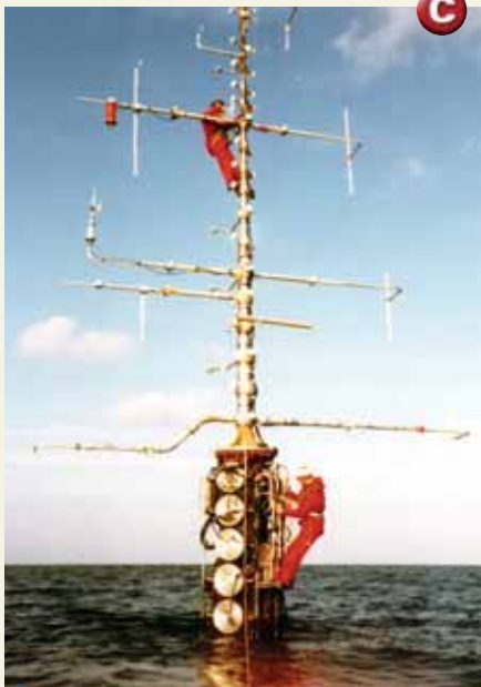
▲ Dos mecánicos realizan trabajos de mantenimiento en una boya meteorológica del Pacífico
